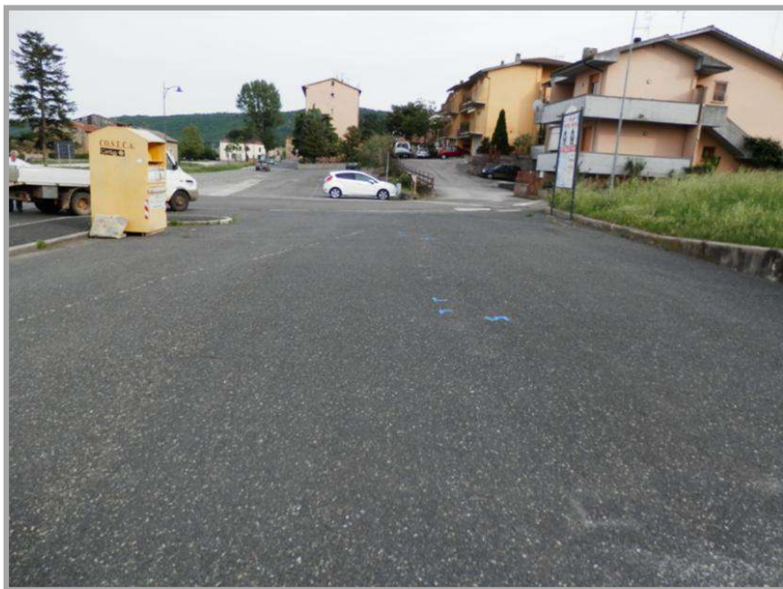
Foto “ 28” – Vista delle particelle di terreno al F. 145 Part 332 e Part 341 sub – Appezamento di terreno classificato come Parcheggio Pubblico Art 32 N.T.A. R.U.
