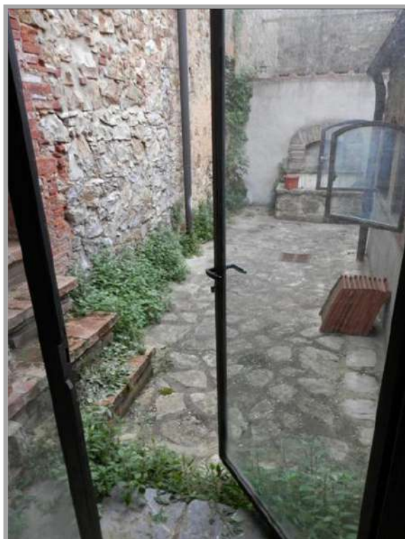
Foto “ 24” – Vista della porta di accesso dal soggiorno alla corte a comune con altre unità immobiliari identificata dal sub 3 con accesso diretto dall’appartamento al sub 4 (Piano T) (SI VEDA NOTA TECNICA NON CONFORMITA’ IN PERIZIA)
