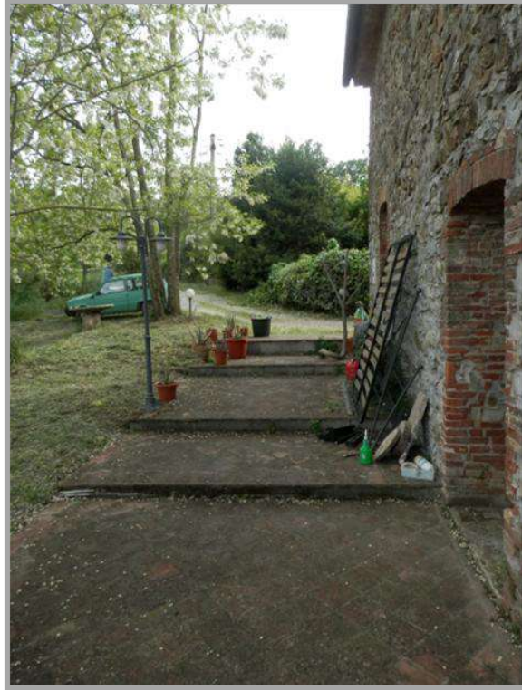
Foto “ 17” – Vista della corte a comune (sub 1) e della porzione del fabbricato interessata al piano terreno dall’appartamento al sub 5
