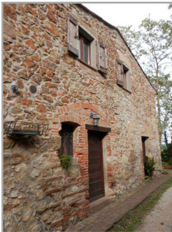
Foto “ 1 ” – Vista della porzione di fabbricato interessata dall'appartamento identificato dal sub 4
