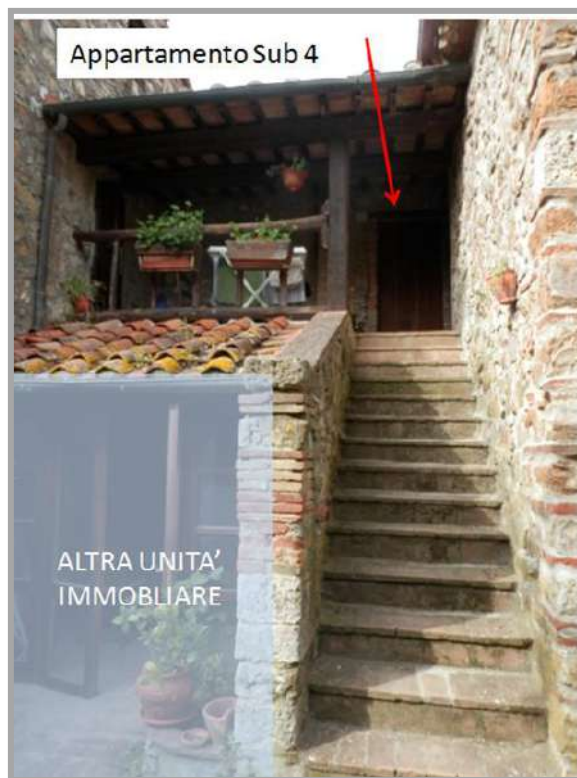
Foto “ 2 ” – Vista delle scale di accesso e del porticato a servizio del sub 4
