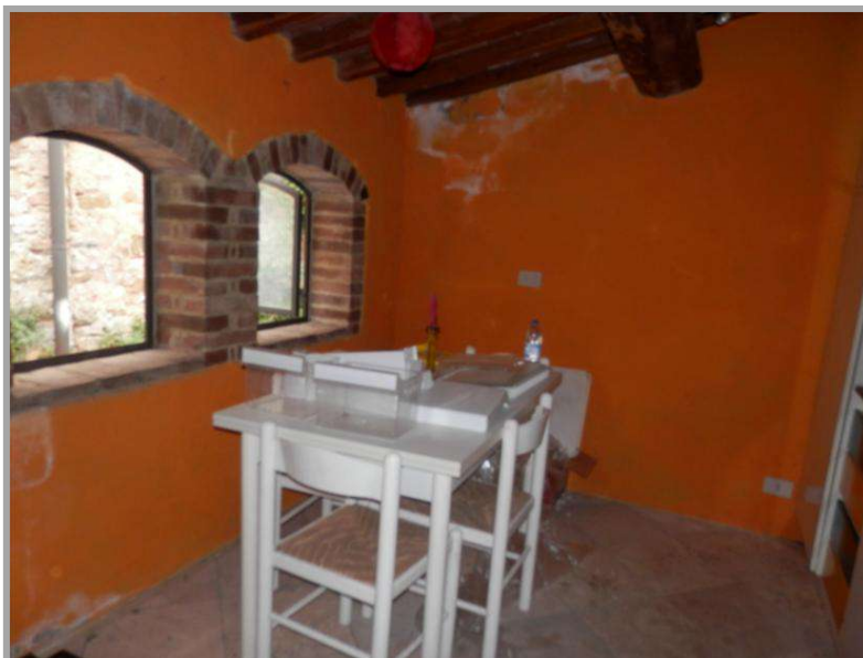
Foto “ 23” – Vista della lavanderia dell’appartamento al sub 4 (Piano T) (Si noti che allo stato attuale nella lavanderia risulta installata una cucina con i fuochi – SI VEDA NOTA TECNICA NON CONFORMITA’ IN PERIZIA)
